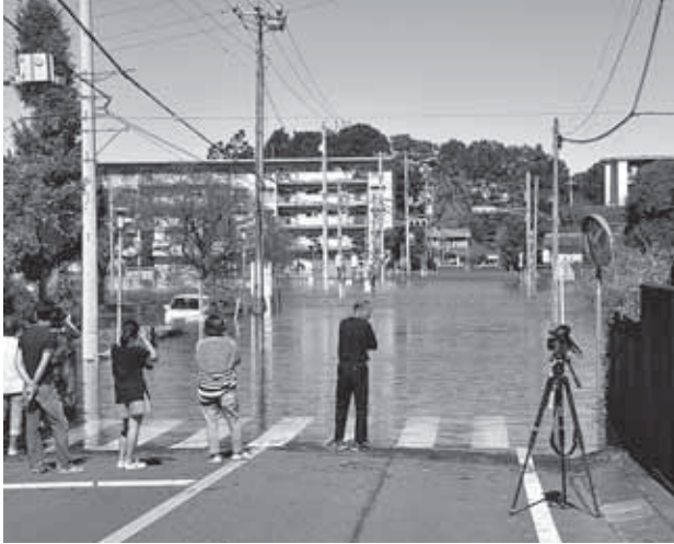
東坂戸団地内の様子
